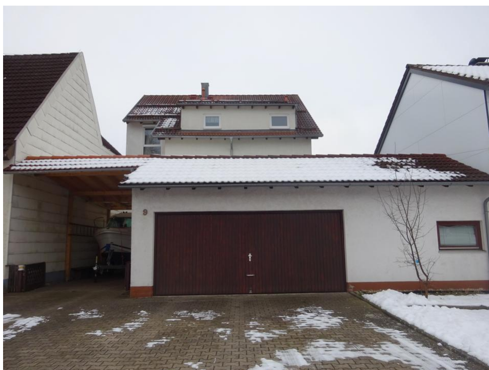
Hausansicht Garage mit Wohnhaus
