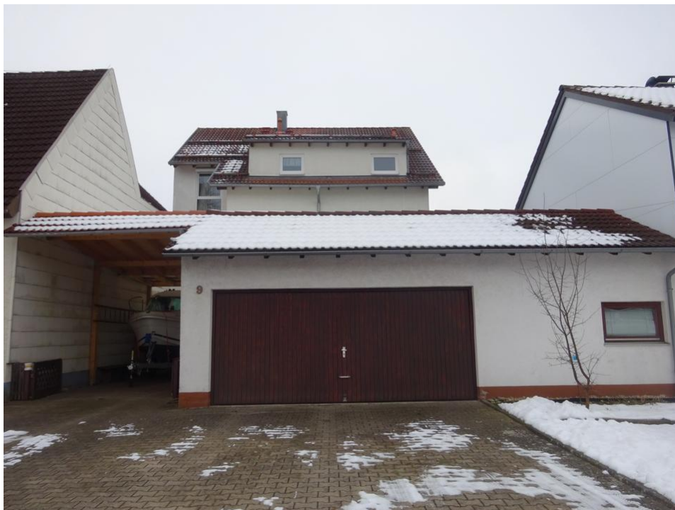
Hausansicht Garage mit Wohnhaus
