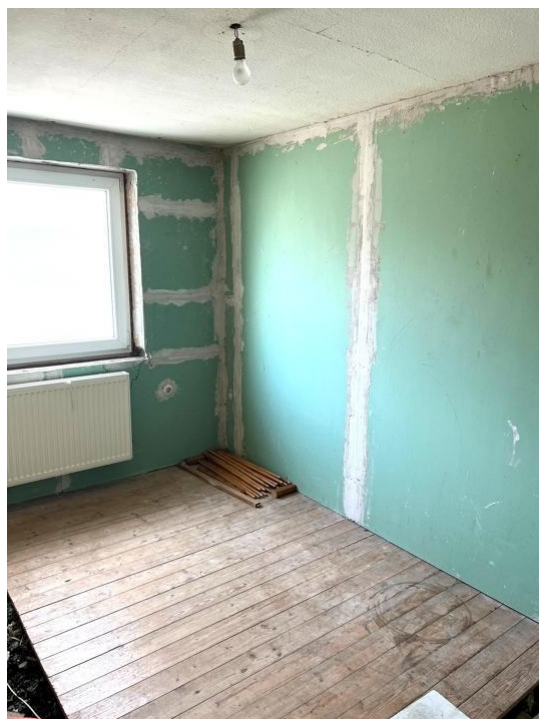
vorbereitetes Badezimmer OG
