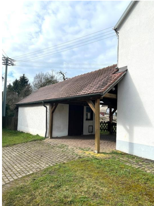
Carport und Lagerhütte
