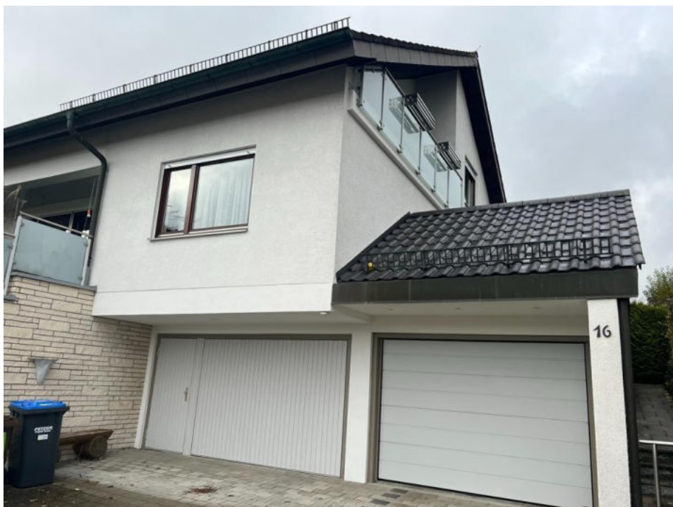
Hausansicht mit Garage
