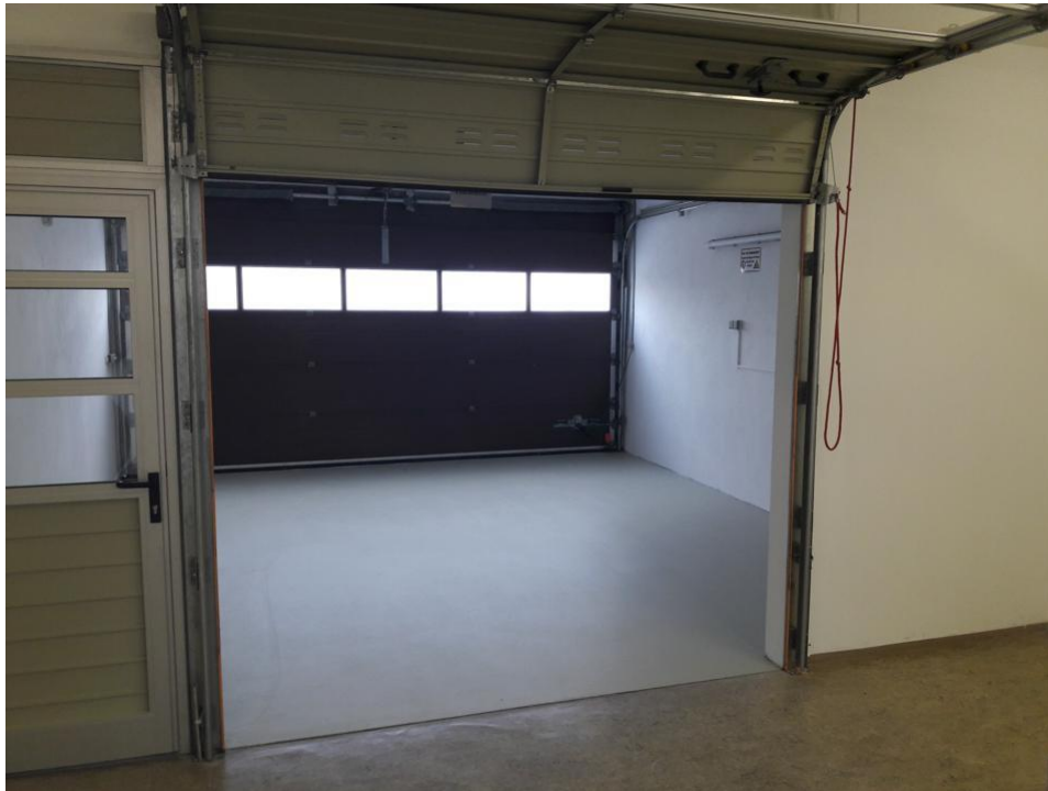
Eingang Rolltor mit Schleuse
