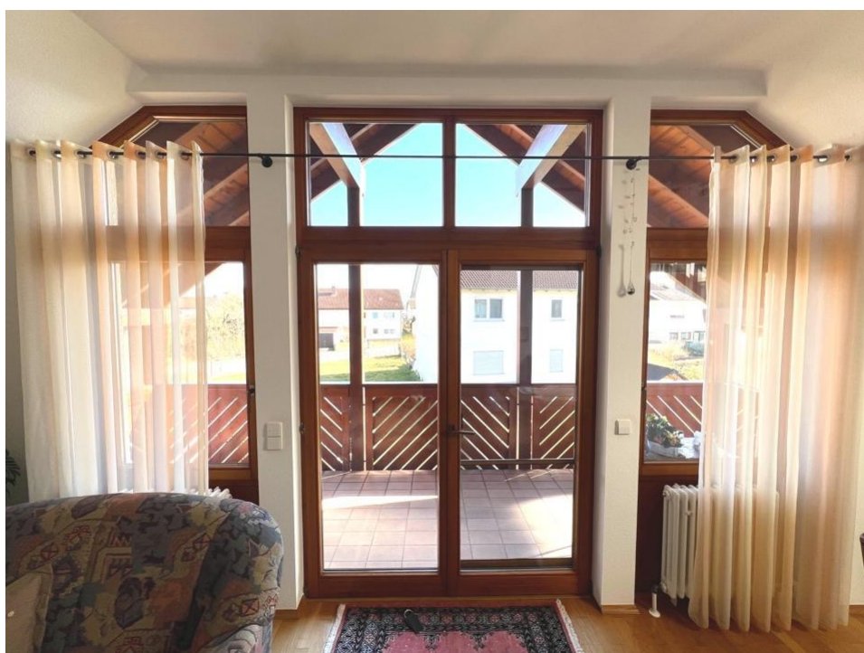
Zugang Balkon DG
