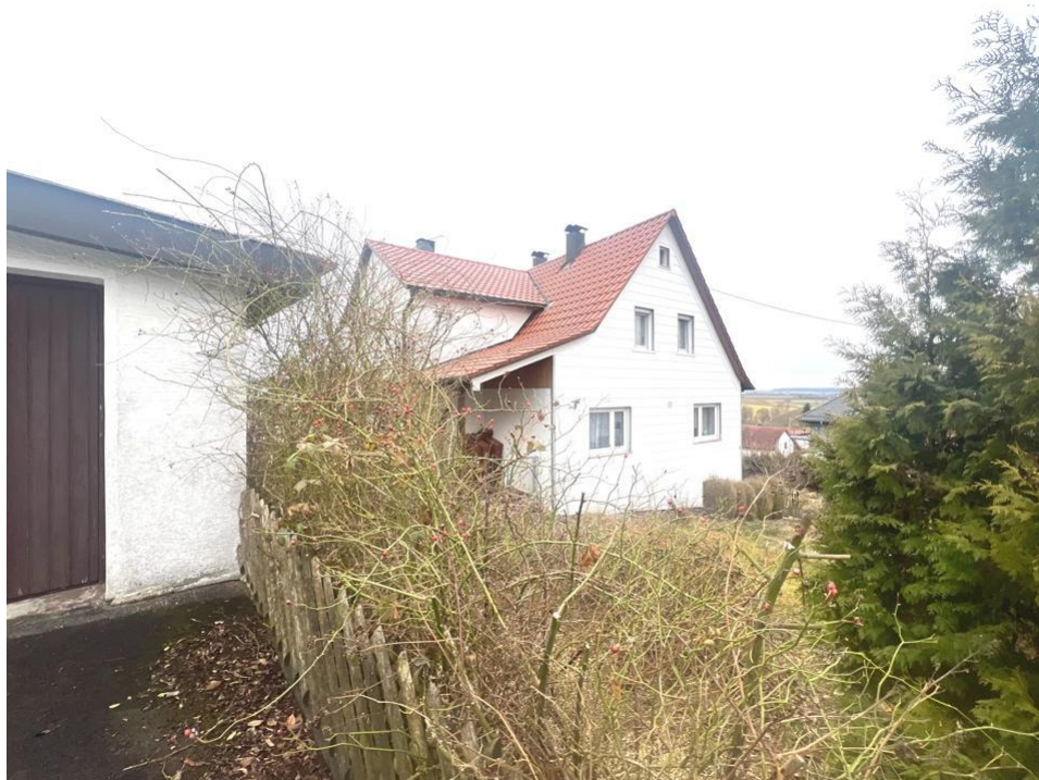
Hausansicht mit Garage
